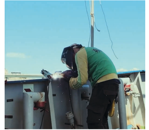
Schweißarbeiten an der Reling. (Bild: Yahya Shaar)
