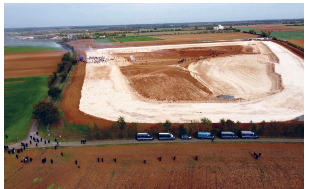
Die Baustelle für das Mégabassin in Sainte-Soline
