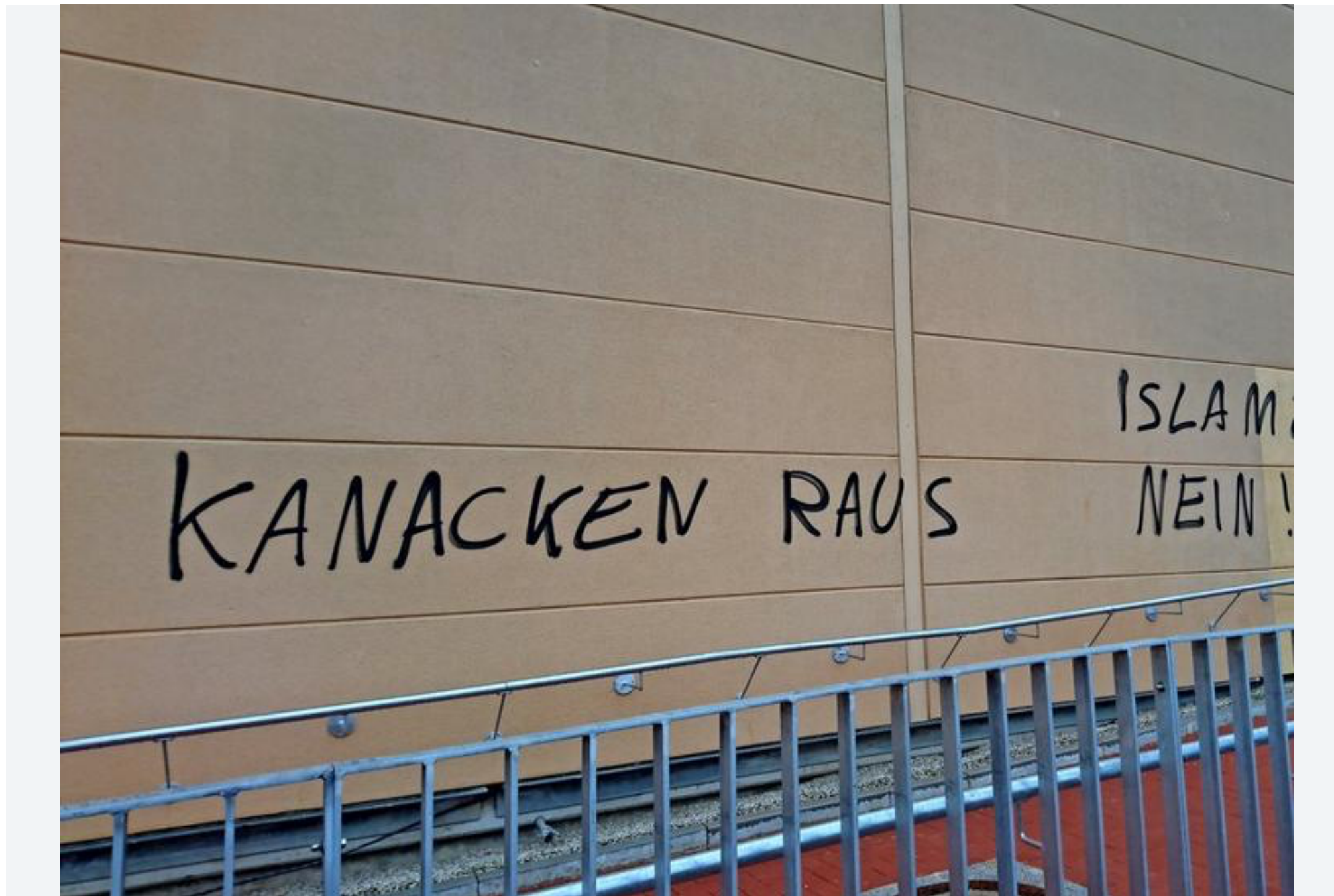
An der Außenfassade der Sporthalle der KGS Ronnenberg haben Unbekannte fremdenfeindliche Parolen hinterlassen. Quelle: Finn Bachmann
