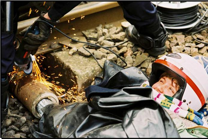
Die einzige Möglichkeit die Blockierenden herauszulösen besteht darin, das Rohr in der Mitte zu öffnen und so direkt die Verkettung zu durchtrennen. Je nach Art der Lock-On-Aktion müssen dann besondere Einheiten mit technischem Gerät angefordert werden. Das heißt, es kommt auch schweres Gerät wie Flexen,
