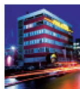
Nüchterner Bau: das „Paradise“ am Rande von Stuttgart
